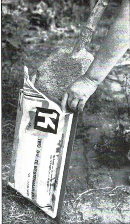
Het 'dempingskussen' wordt met zand gevuld.
